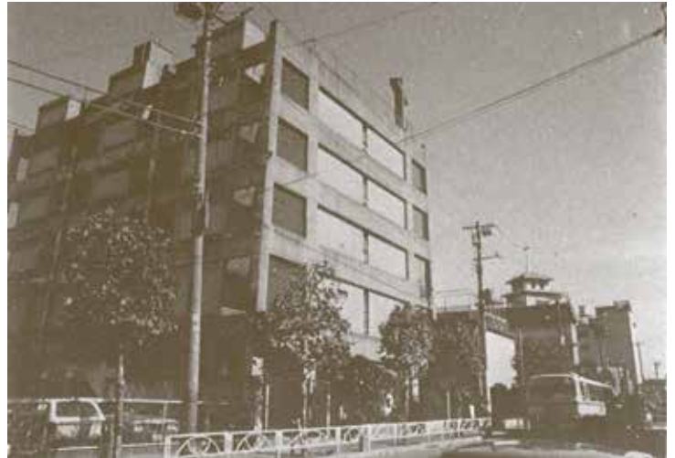
本所ベタニヤ母子寮（令和元年解体）
